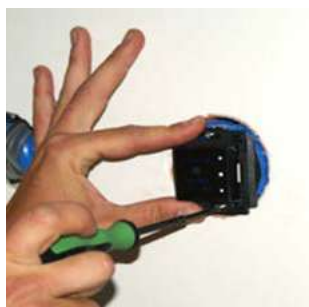
Sluit hoofdbediening aan op aansluitkabel
