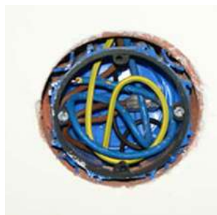
Zorg dat aansluitkabel spanningsloos is
